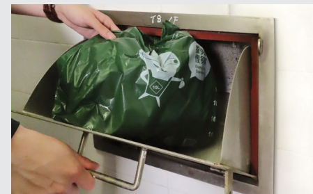
樓層垃圾槽口
