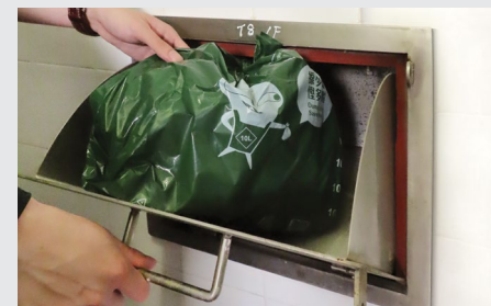
樓層垃圾槽口
