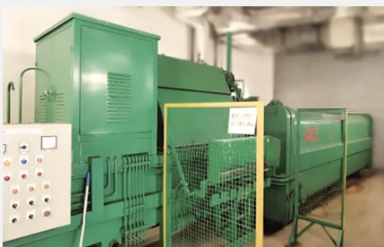
垃圾斗沒有內置壓縮系統，垃圾房需設置固定的壓縮系統
