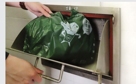
樓層垃圾槽口
