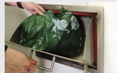
樓層垃圾槽口
