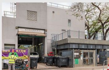
市區離街垃圾站
