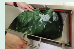
樓層垃圾槽口
