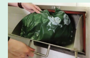
樓層垃圾槽口
