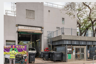
市區離街垃圾站
