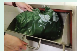
樓層垃圾槽口
