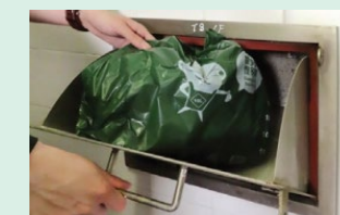
樓層垃圾槽口
