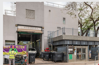
市區離街垃圾站
