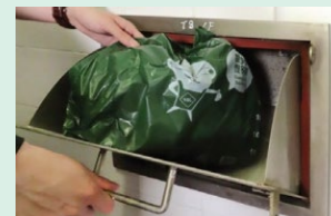
樓層垃圾槽口
