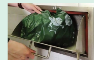
樓層垃圾槽口
