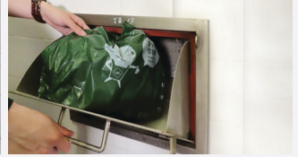
फोहोर पठाउने नाली पाइपहरू (चुटहरू)को भित्र फाल्ने प्वालहरू (इन्लेटहरू)
