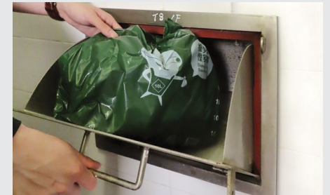
樓層垃圾槽口
