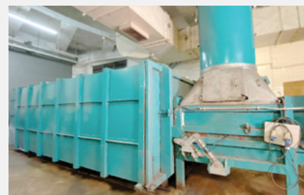
透過地下真空吸管將投入每層垃圾槽口的垃圾輸送到中央垃圾站的離心室，經壓縮後再運走
