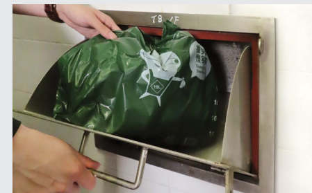
樓層垃圾槽口
