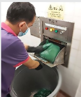
清潔員工把以指定袋包妥的垃圾棄置於連接自動垃圾收集系統的垃圾槽口內
