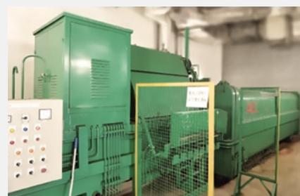
垃圾斗沒有內置壓縮系統,垃圾房需設置固定的壓縮系統
