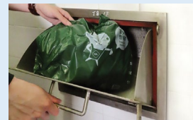
樓層垃圾槽口
